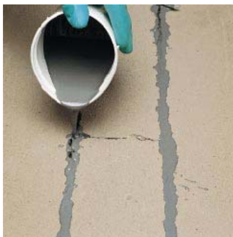
Заполнение трещин в бетоне. Нанесение EPORIP .
