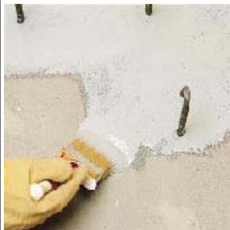
нанесение EPORIP кистью
