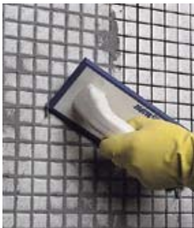
Заполнение швов стеклянной мозаики шпателем
