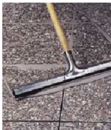
Заполнение швов гранитной облицовки перед полировкой
