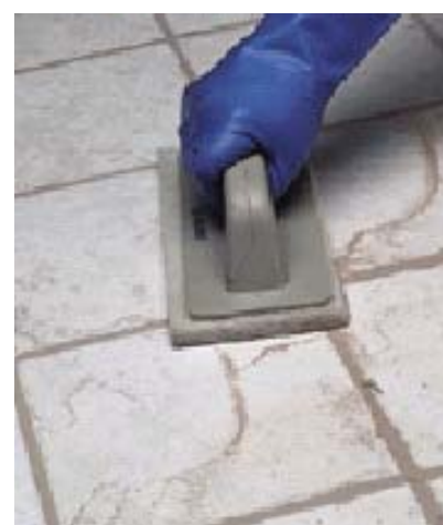
Очистка с помощью мягкой кельмы
