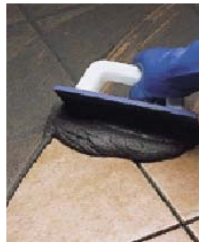
Расшивка однообжиговой плитки с помощью кельмы
