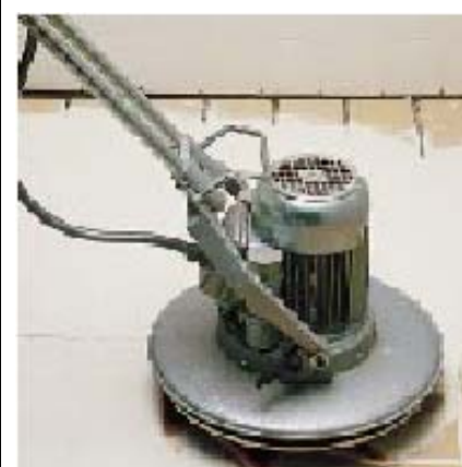
Нанесение с помощью затирочной машины
