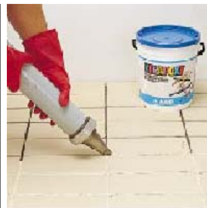
Нанесение с помощью ручного пистолета
