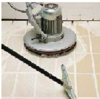
Очистка с помощью затирочной машины
