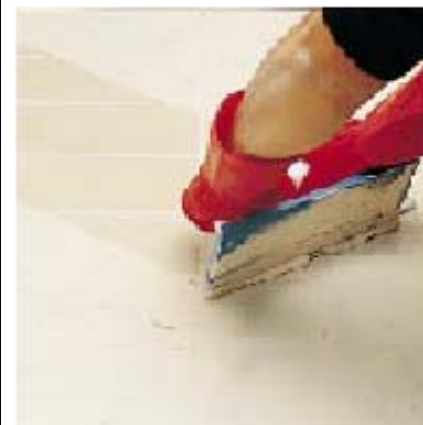
Удаление избыточного материала с помощью резинового мастерка
