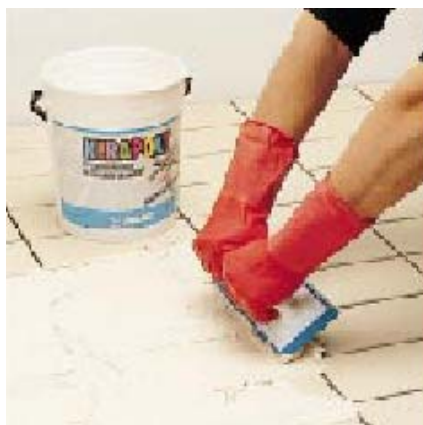
Нанесение с помощью резинового мастерка
