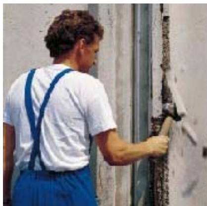
удаление разрушенного бетона
