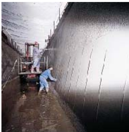
выравнивание шпателем
