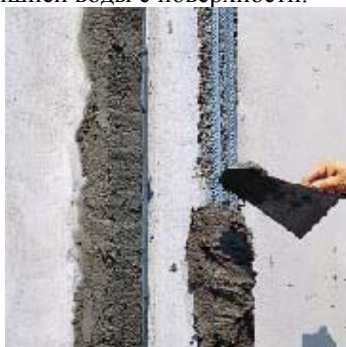
нанесение материала шпателем
