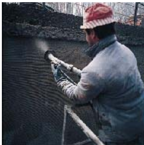
нанесение распылением
