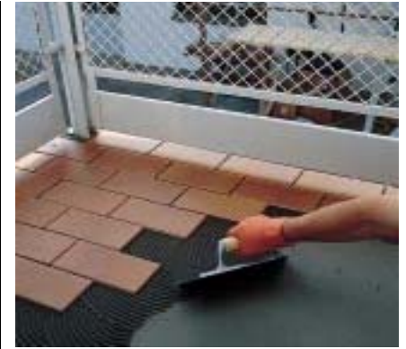
укладка плитки на гидроизоляцию MAPELASTIC с помощью клея GRANIRAPID
