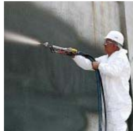
распыление MAPELASTIC по стенке с волосяными трещинами
