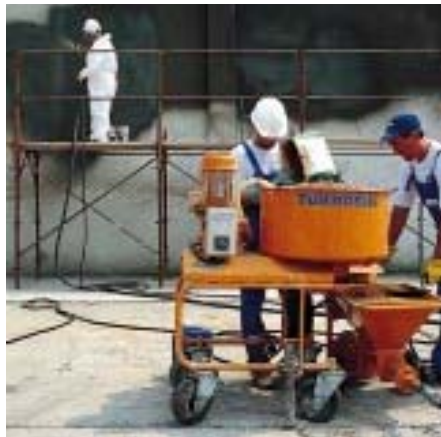
смешивание MAPELASTIC в вертикальном миксере
