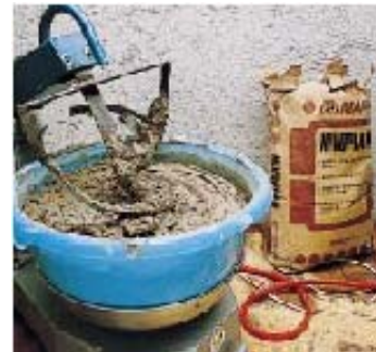
Замешивание NIVOPLAN -а на мини-миксере
