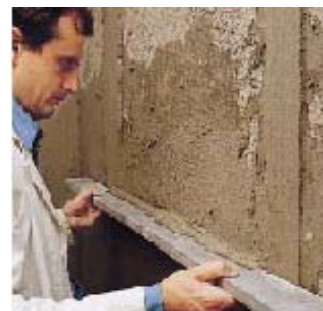
Выравнивание слоя NIVOPLAN рейкой
