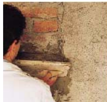
Реставрация NIVOPLAN -ом старой кирпичной стены
