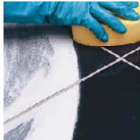
Расшивка швов облицовки из натурального камня. ULTRACOLOR №50 (титан)
