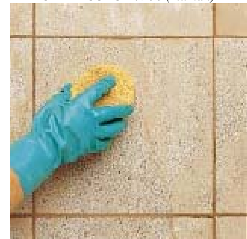
Расшивка швов облицовки из гранита. ULTRACOLOR №50 (титан)
