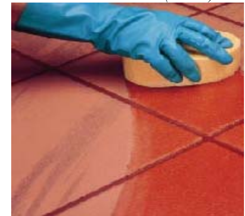
Расшивка швов облицовки из "котто тоскано." ULTRACOLOR №54 (терракотта)
