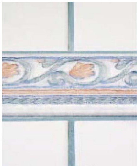
расшивка швов составом ULTRACOLOR (цвет 63 турмалин)
