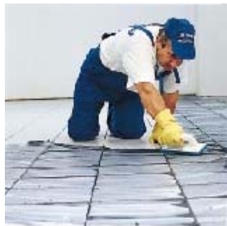
Нанесение ULTRACOLOR с помощью резинового шпателя
